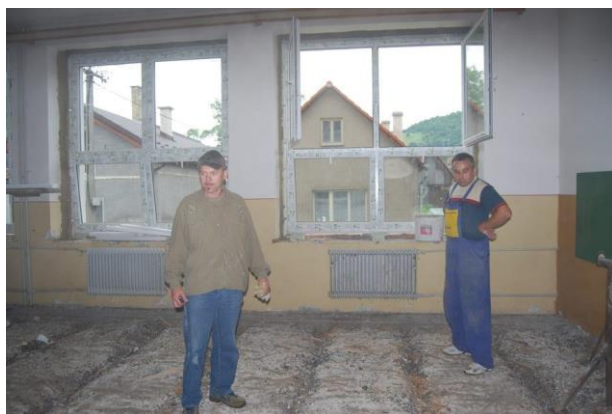
Obnova školy – práce vnútri
